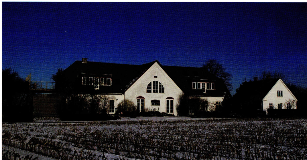
Kragekær Mejeri 2011. (Foto: Palle Berg)
