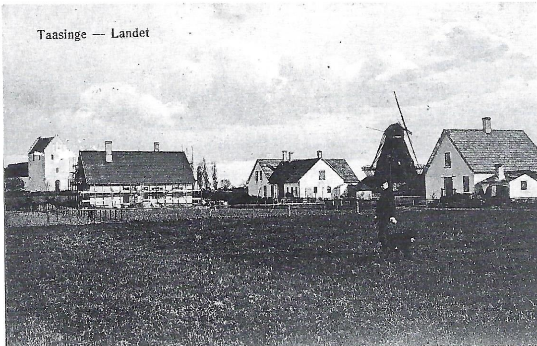
Landet bageri under opførelse ca. 1909.
